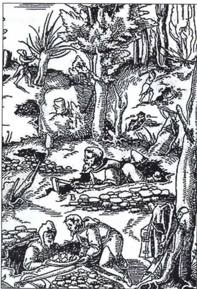
Středověký kutací příkop. Podle J. Agricoly (Dvanáct knih o hornictví a hutnictví, orig. 1556, překlad Berlin 1928, str. 32).
